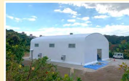
農水一体システム 実証施設 (フィールドセンター内)
