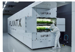
密閉型構造の植物工場
